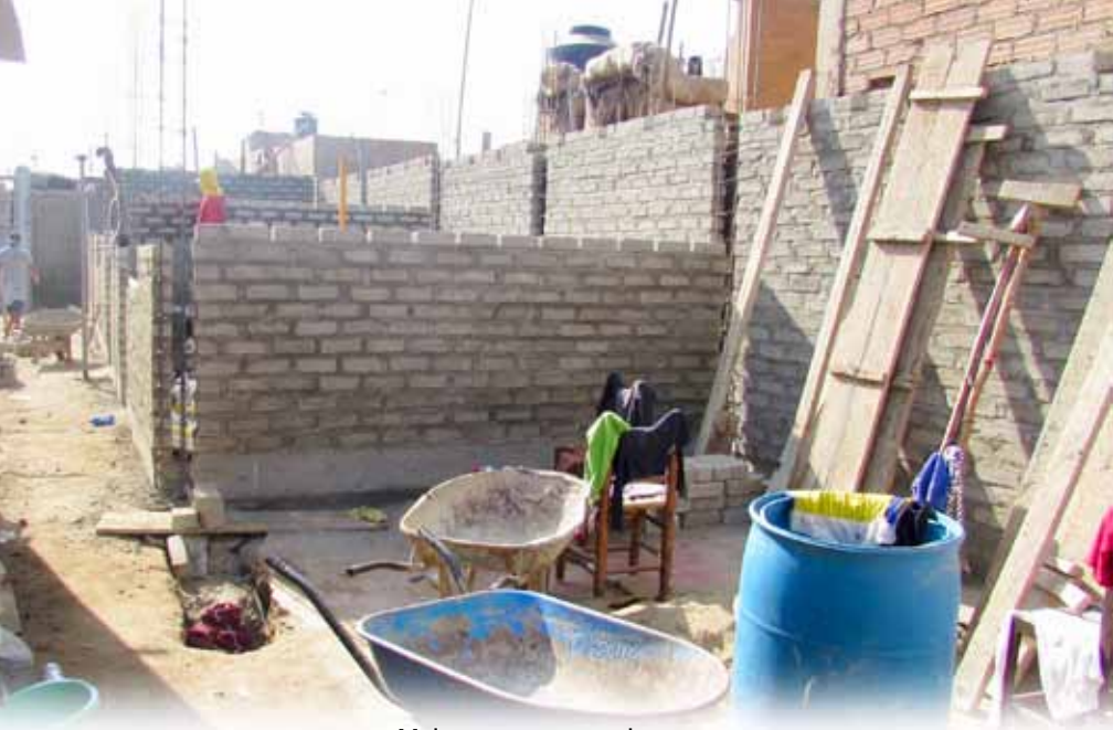
Maisons en construction
