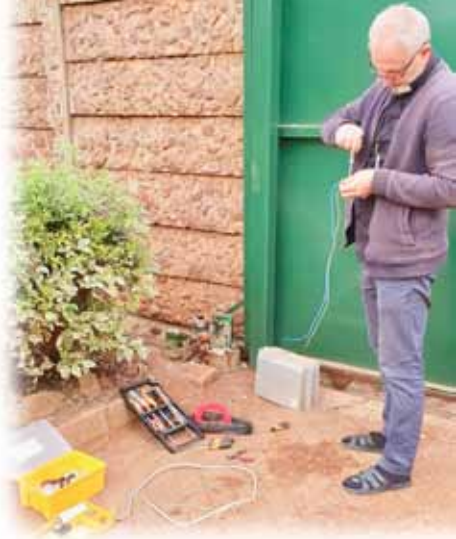
Le Père Greg installe le mécanisme d'une barrière à coulisse
