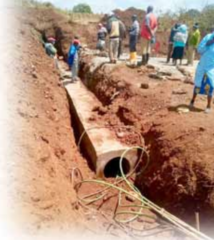
Des tranchées sont creusées pour le projet d'eau à la ferme Kiirua
